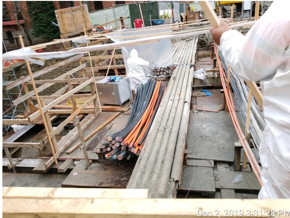
Damaged Verizon Conduits
